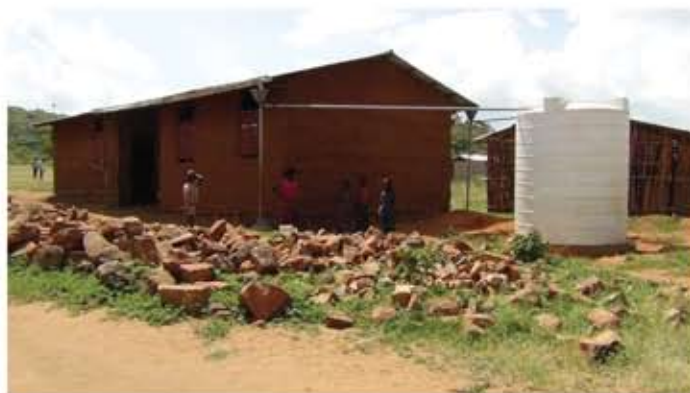
Zbiorniki instalowane w szkołach to prawie 10 000 litrów czystej wody dla uczniów.
