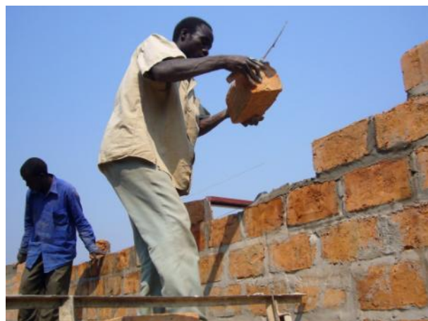
Szkolenie murarskie - układanie cegły
