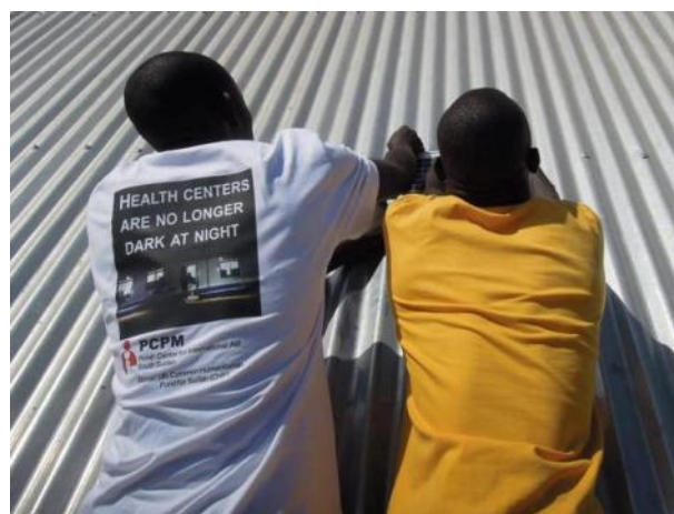
Instalacja panela słonecznego na dachu jednego z ośrodków zdrowia
