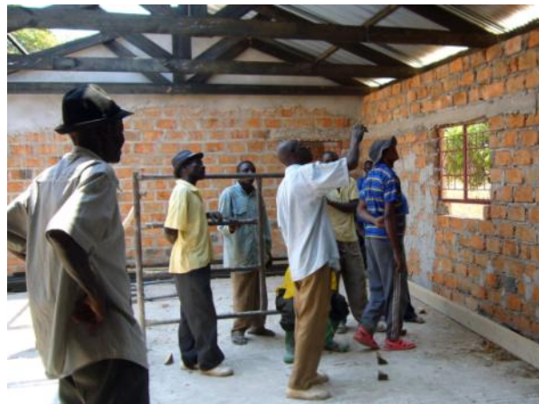
Szkolenie stolarskie - montaż więźby dachowej
