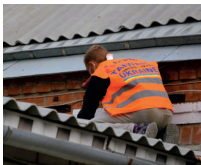
Naprawa dachu w Cyrkunach
