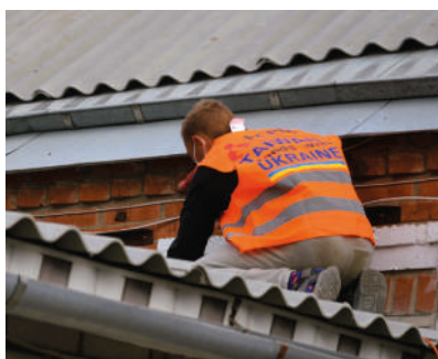
Naprawa dachu w Cyrkunach
